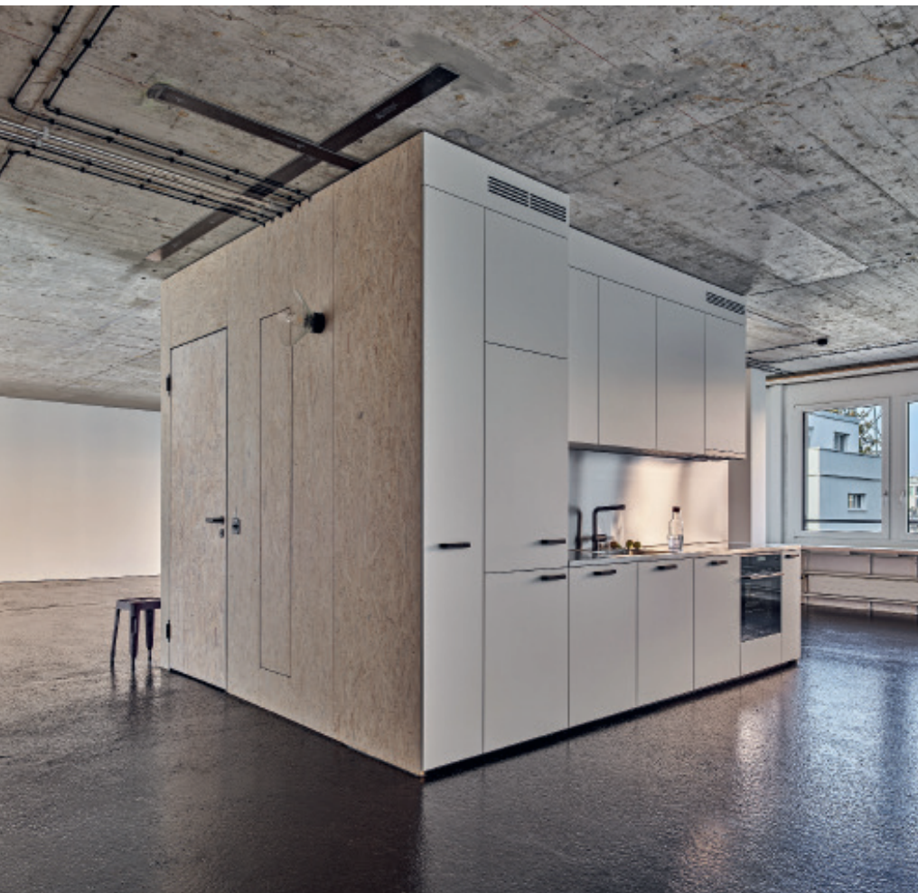
Sichtbetondecken und Gussasphalthöden tragen die Spuren der Vornutzung bewusst zur Schau. BILDER: ROGER FREI
